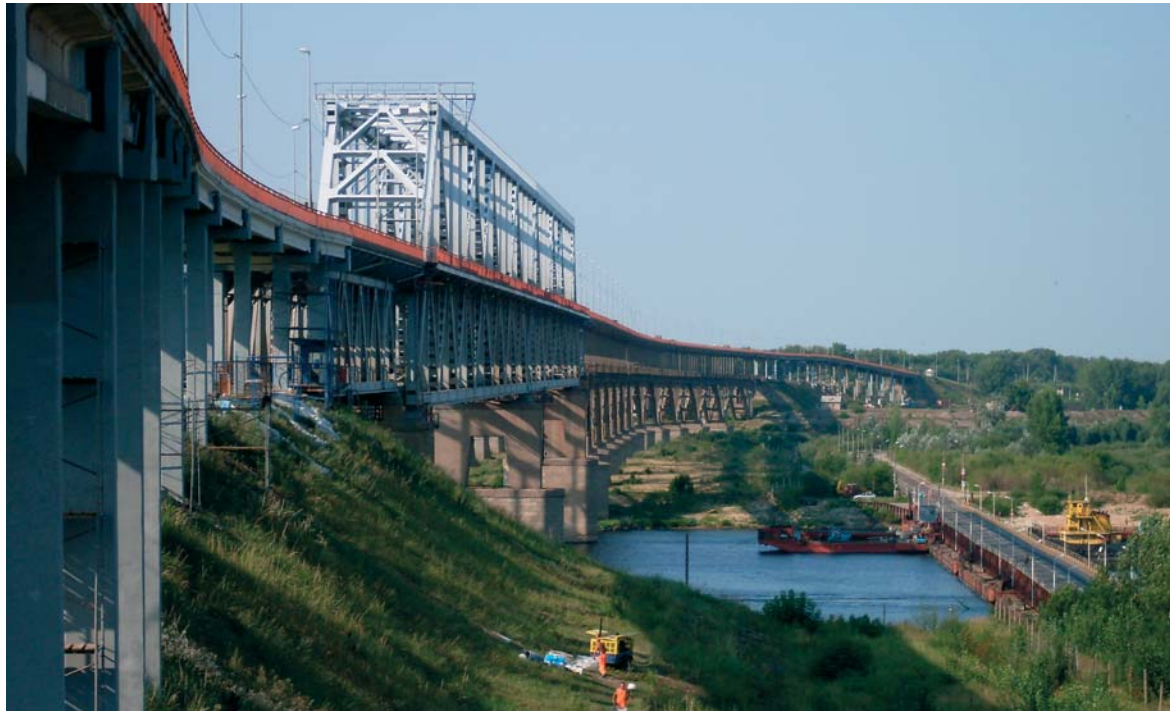
Мост через р. Волга в Нижнем Новгороде
